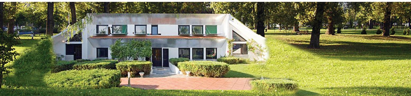
U odnosu na klasičnu kuću, solarna zemunica pokrivena je sa tri strane slojem zemlje debljine oko 50 cm. Otvorena je samo sa južne strane, i to prozorima iznad kojih je nastrešnica. Donji kapci su pokretni tako da se mogu zatvarati i otvarati. Na krovu, zadnjoj i pobočnim stranama je travnjak
