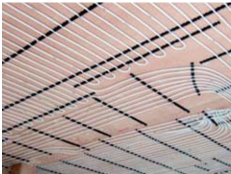
NAJVEĆI ŠTEDIŠA: Toplotna pumpa i sistem podnog grejanja i hlađenja (Foto: www.centrala.org.rs )
