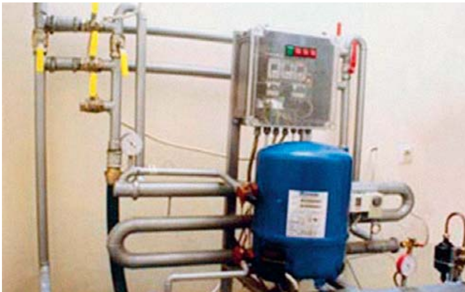
NAJVEĆI ŠTEDIŠA: Toplotna pumpa i sistem podnog grejanja i hlađenja (Foto: www.centrala.org.rs )
